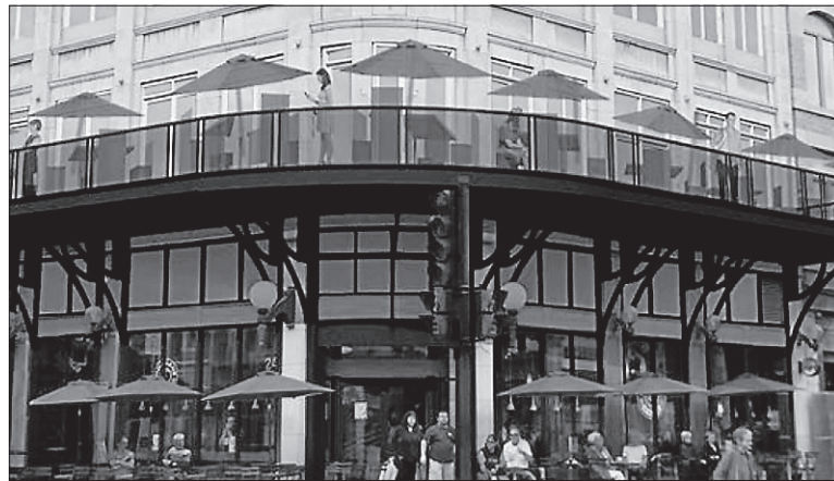
Le projet de terrasse du bar Le Manhattan surplombera le coin des rues des Forges et Notre-Dame Centre au centre-ville de Trois-Rivières.
