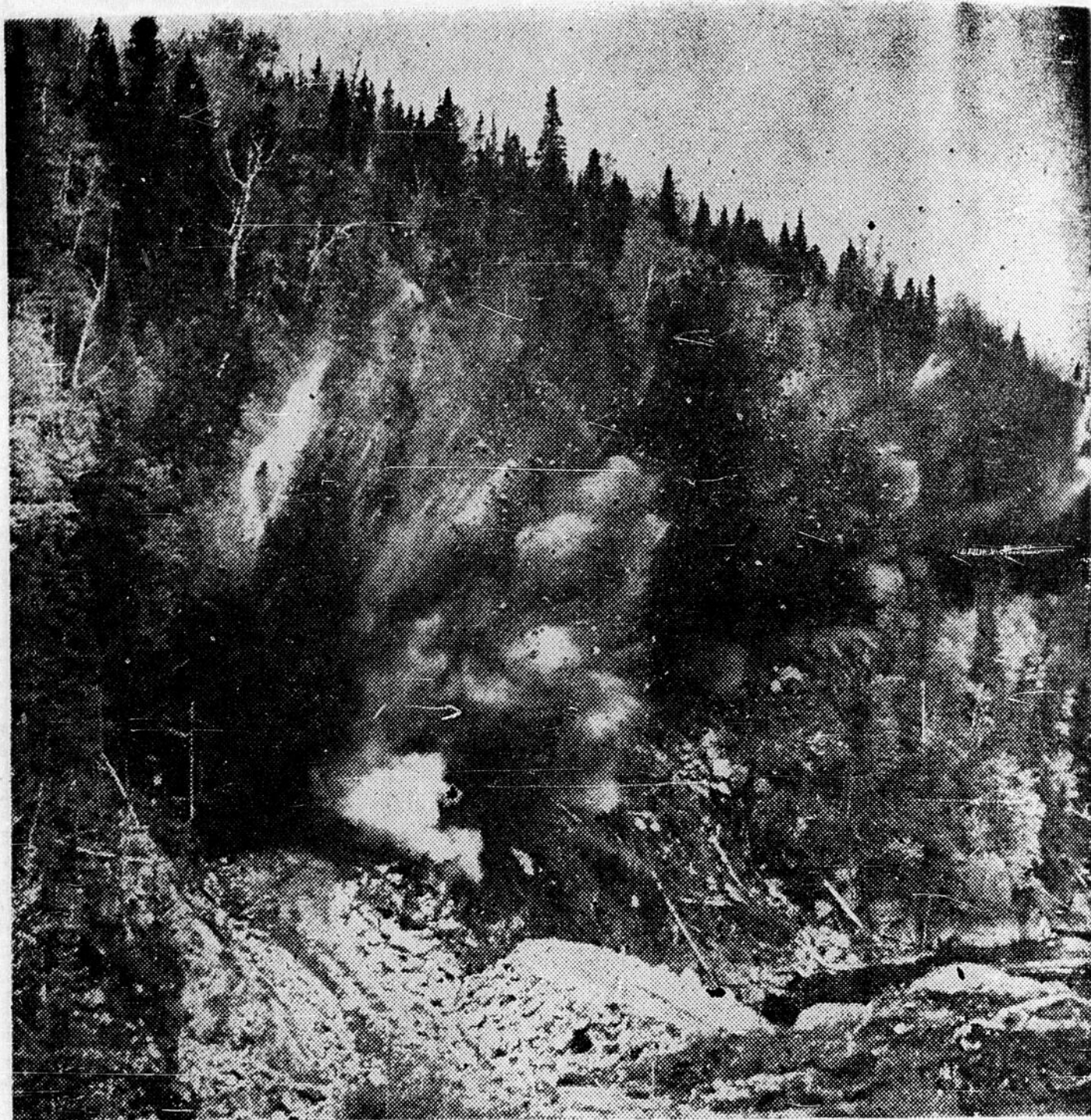
Des centaines de tonnes de roc sont réduites en poussière. Il a fallu plusieurs jours de travail pour aboutir à cette explosion qui ne durera qu'une fraction de seconde.
