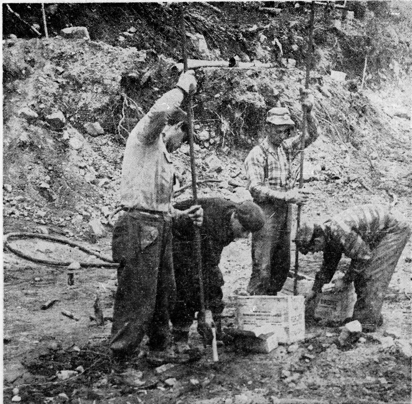
Grâce à la dynamite on parvient à se tailler un passage dans le flanc des montagnes. Dans la vallée de la rivière Cran, à 26 milles au nord-ouest de St-Félicien, plus de 25,000 livres de dynamite seront requises pour une seule explosion.
