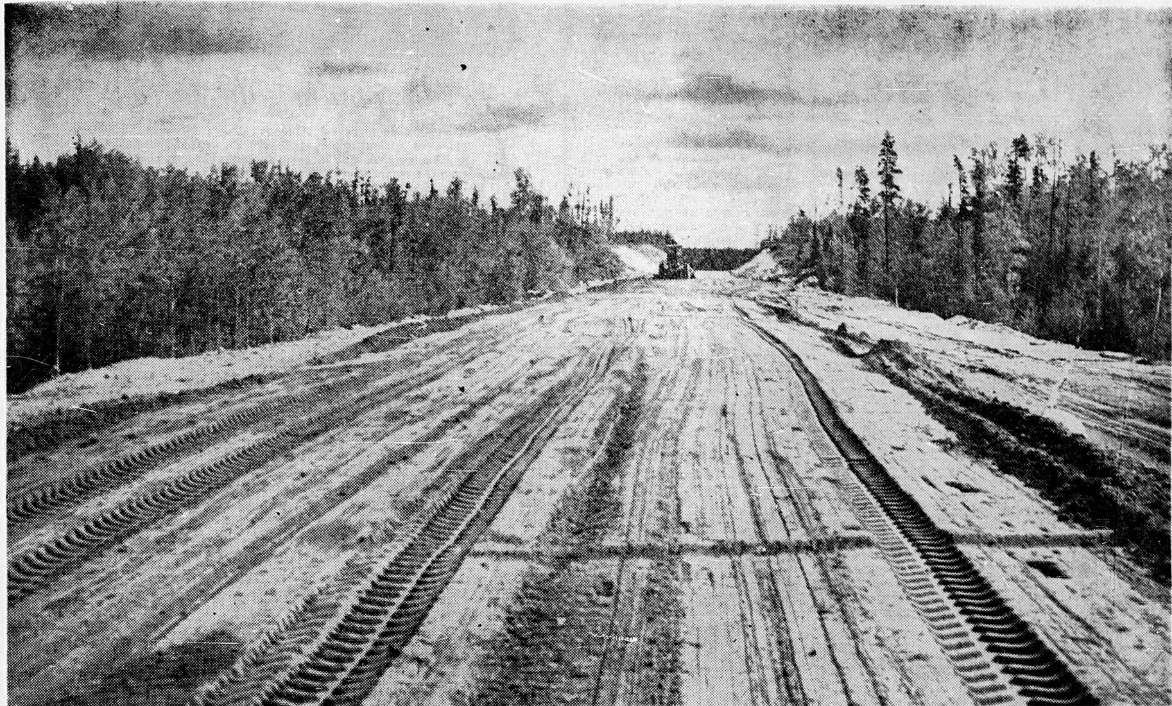
Le terrassement de la voie constitue une étape importante de la construction ferroviaire. Le rail, en effet, doit reposer sur une surface aussi horizontale que possible. Voilà pourquoi, dans des régions aussi accidentées que le nord québécois, la construction ferroviaire est un véritable défi à l'invention de l'homme.
