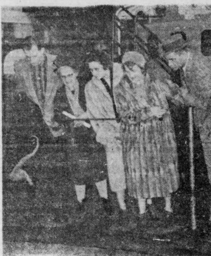
UNE GENERATRICE OUVERTE — C'est dans ce puits qui fait plus que deux planchers que se trouve d'ordinaire la génératrice d'électricité. — Dans l'ordre habituel, sur la première photo, M. Raymond Girard, soudeur, Mmes Benoit et Raymond Girard, Mme Brassard et M. Lucien Bras-
