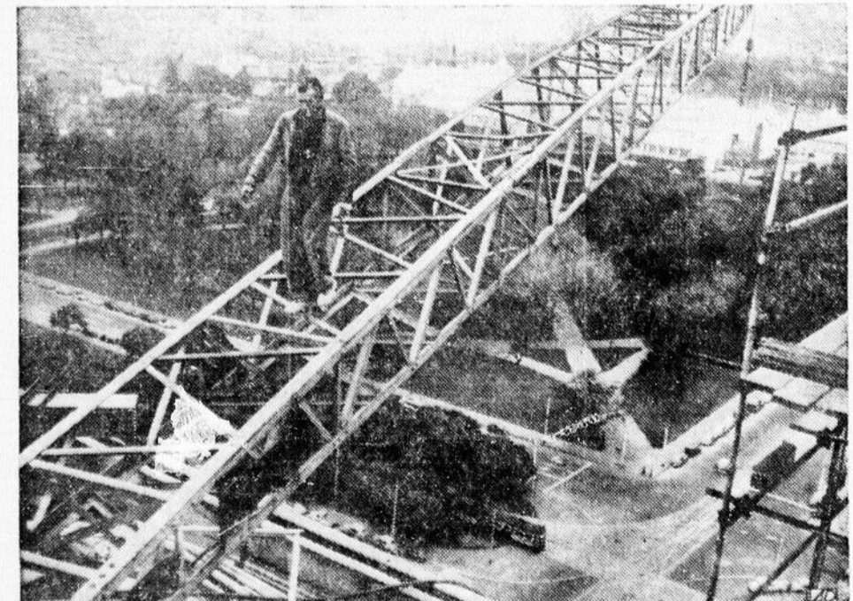
A PAS PRECAUTIONNEUX: Gerrit Mulder vaque à son travail sur le bras d'une grue géante qui se dresse à 250 pieds au-dessus du sol. L'ouvrier est chargé de huiler les rouages de la puissante machine utilisée pour la construction d'un édifice de dix-neuf étages à Melbourne en Australie. (Photo PA)
