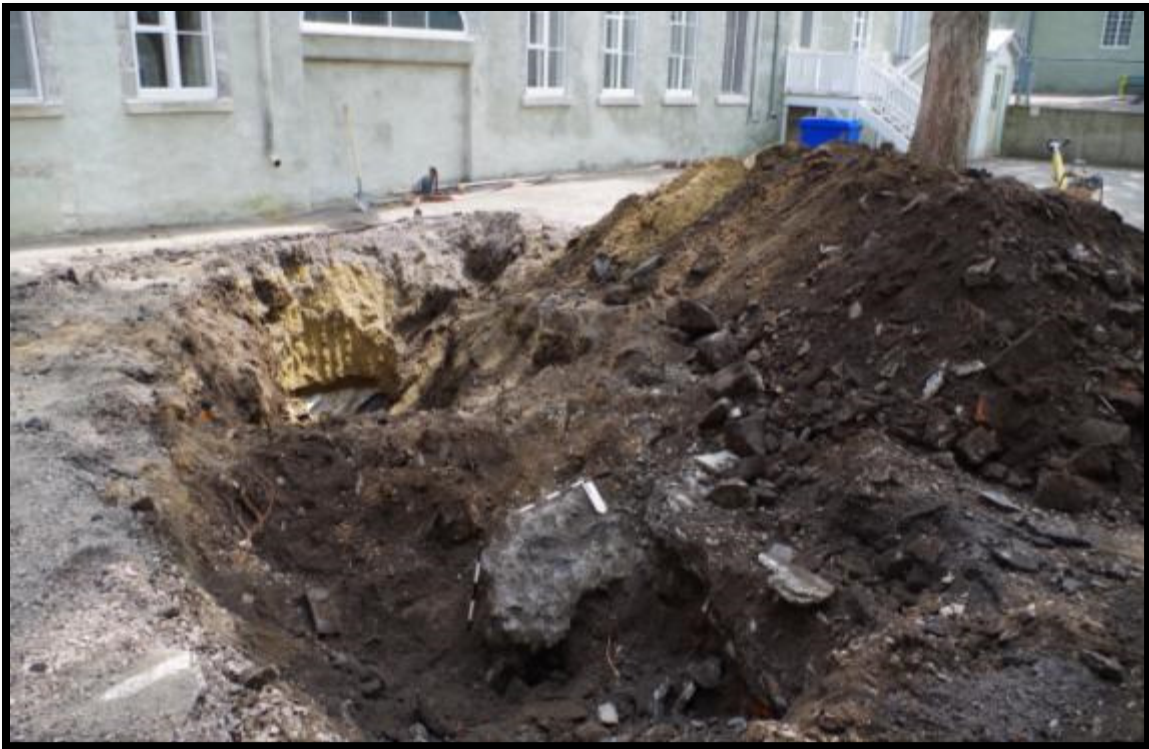
Figure 57. Tranchée d'installation de l'égout pluvial (sable brun jaunâtre) (Photo : S. Noël).
