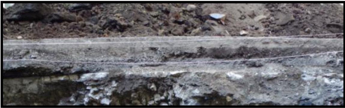
Figure 56. Succession des couches d'asphalte dans la cour intérieure. Détail de la coupe stratigraphique ouest de la sous-opération 9B (Photo : S. Noël).
