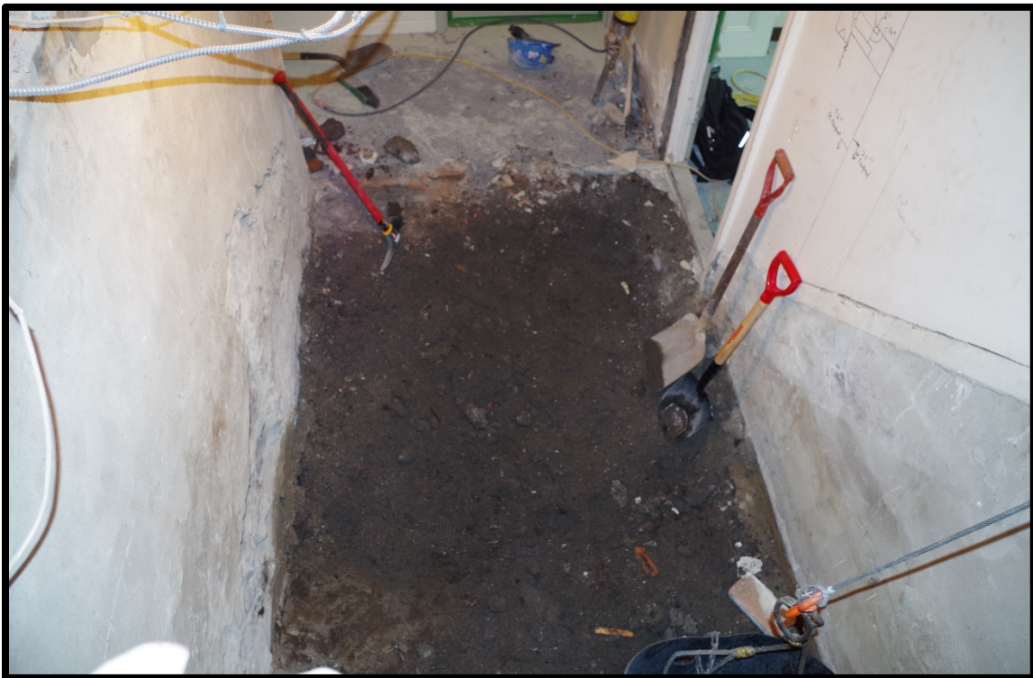
Figure 60. Sous-opération 9C, après l'enlèvement de la dalle de béton moderne (9C1) (Photo : S. Noël).
