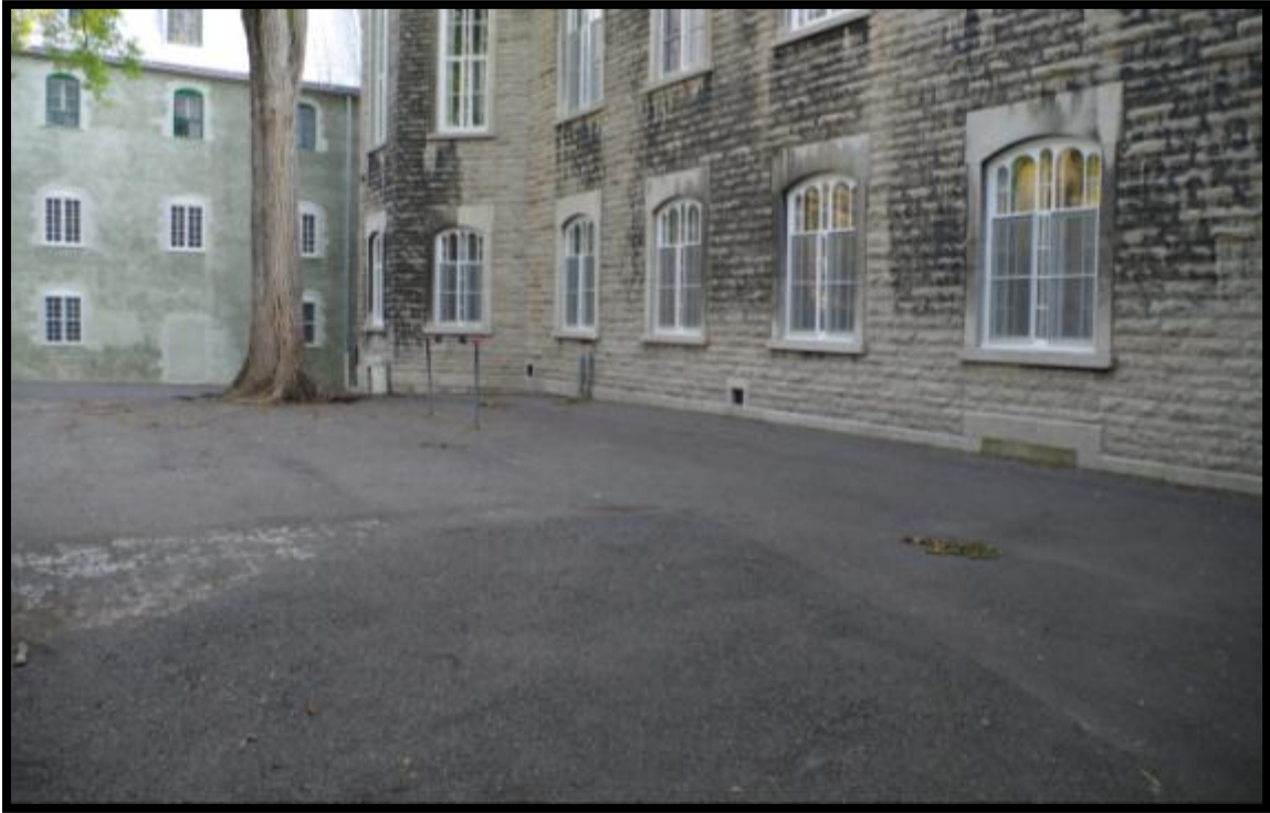
Figure 58. Portion de la cour réasphaltée, à la suite du remplacement de l'égout pluvial près de l'aile des Parloirs en 2004 (Photo : S. Noël).
