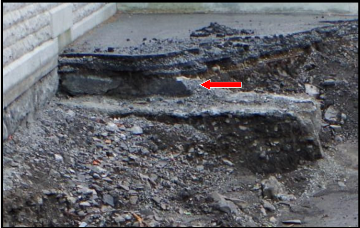
Figure 44. Face nord du vestige de ciment 9A150b. Notez, du côté sud du vestige, une bande étroite de ciment qui fait un décrochement dans la structure de ciment plus large, sous-jacente (Photo : S. Noël).
