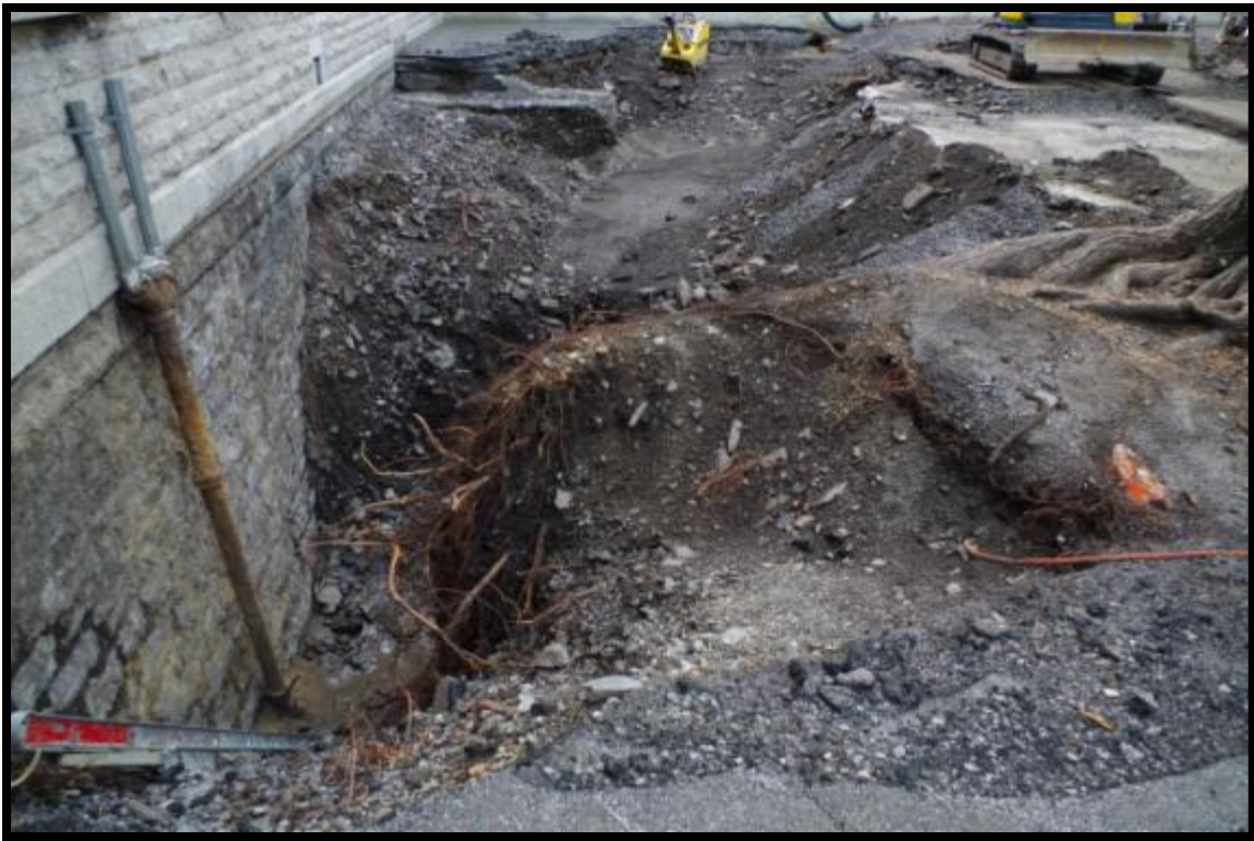
Figure 50. Fondations du chœur des religieuses dégagées lors de la surveillance mécanique de la tranchée 9A (9A100). Les fondations ont été dégagées sur environ 3,60 m de profondeur. La base des fondations n'a pas été atteinte, ce qui suggère qu'elles ont été déposées directement sur le roc. La partie hors-terre du bâtiment est également visible (Photo : S. Noël).
