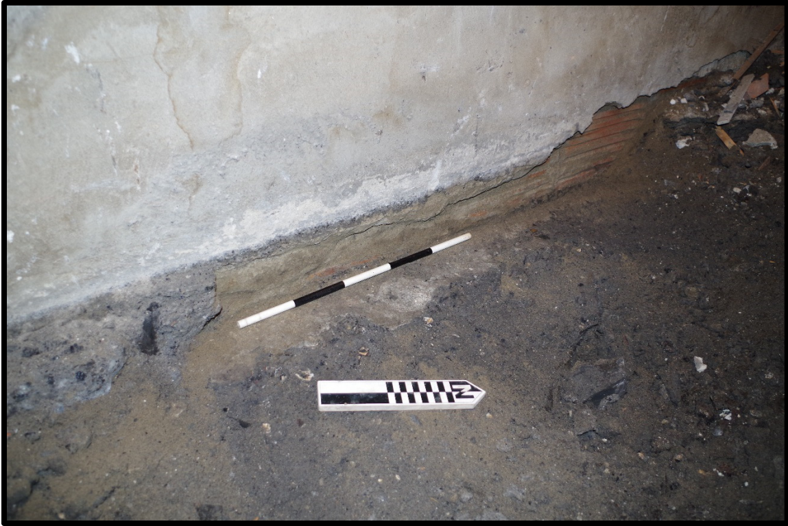
Figure 63. Partie du lot 9C2 (ciment) préservé près du mur à l'ouest de la sous-opération (Photo : S. Noël).
