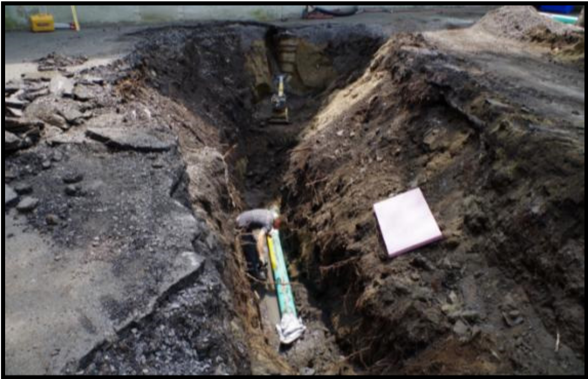
Figure 59. Remplacement du tuyau en fonte par un tuyau en plastique. L'égout en béton est visible en arrière-plan. Vers le sud (Photo : S. Noël).
