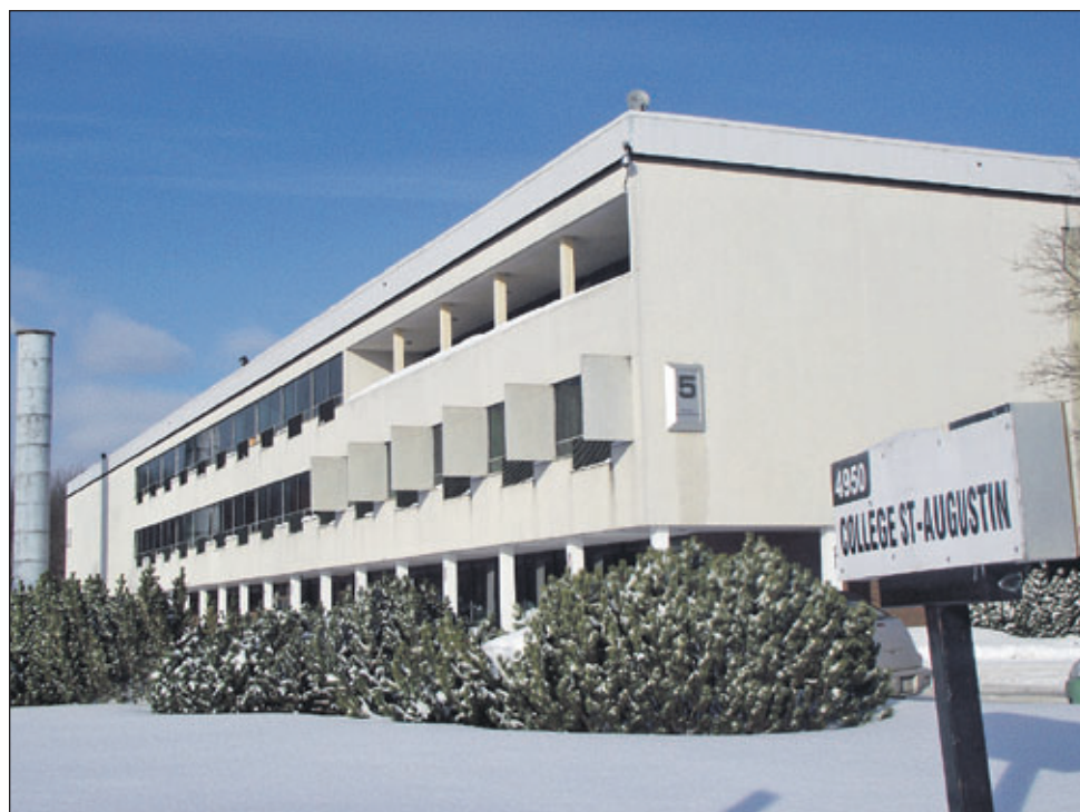
Le Collège de Saint-Augustin est en voie d'être converti en complexe communautaire.
