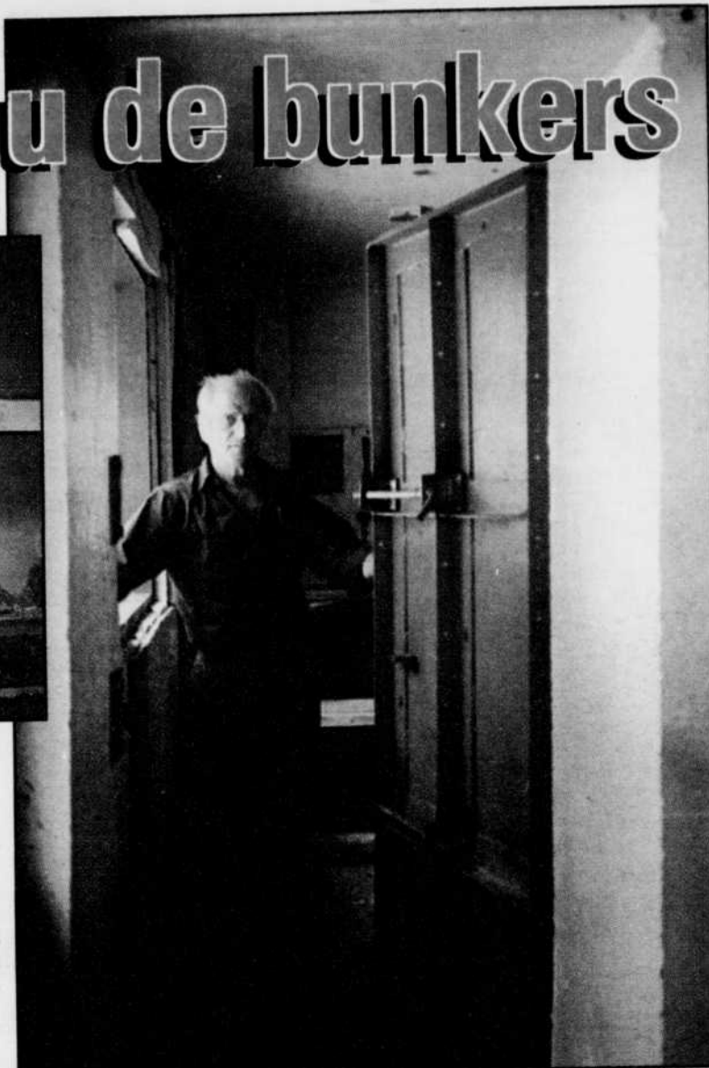
Damien Pouliot à l'intérieur d'un des bâtiments de la SRC. À remarquer, l'épaisseur des murs.
