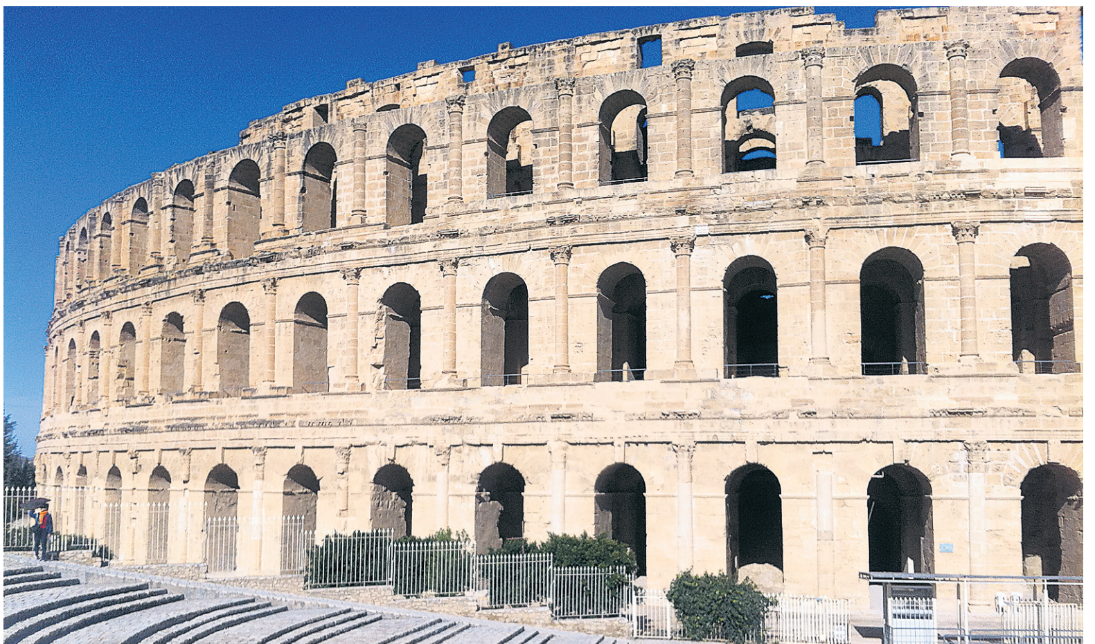
Construit autour du III e siècle, le Colisée d'El Jem est le troisième plus grand pour sa capacité après ceux de Rome et de Vérone.
