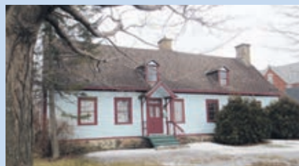
Chambly a lancé l'appel d'offres pour l'élaboration d'un plan de réhabilitation de la maison Boileau. (Photo: TC Media - Archives)
