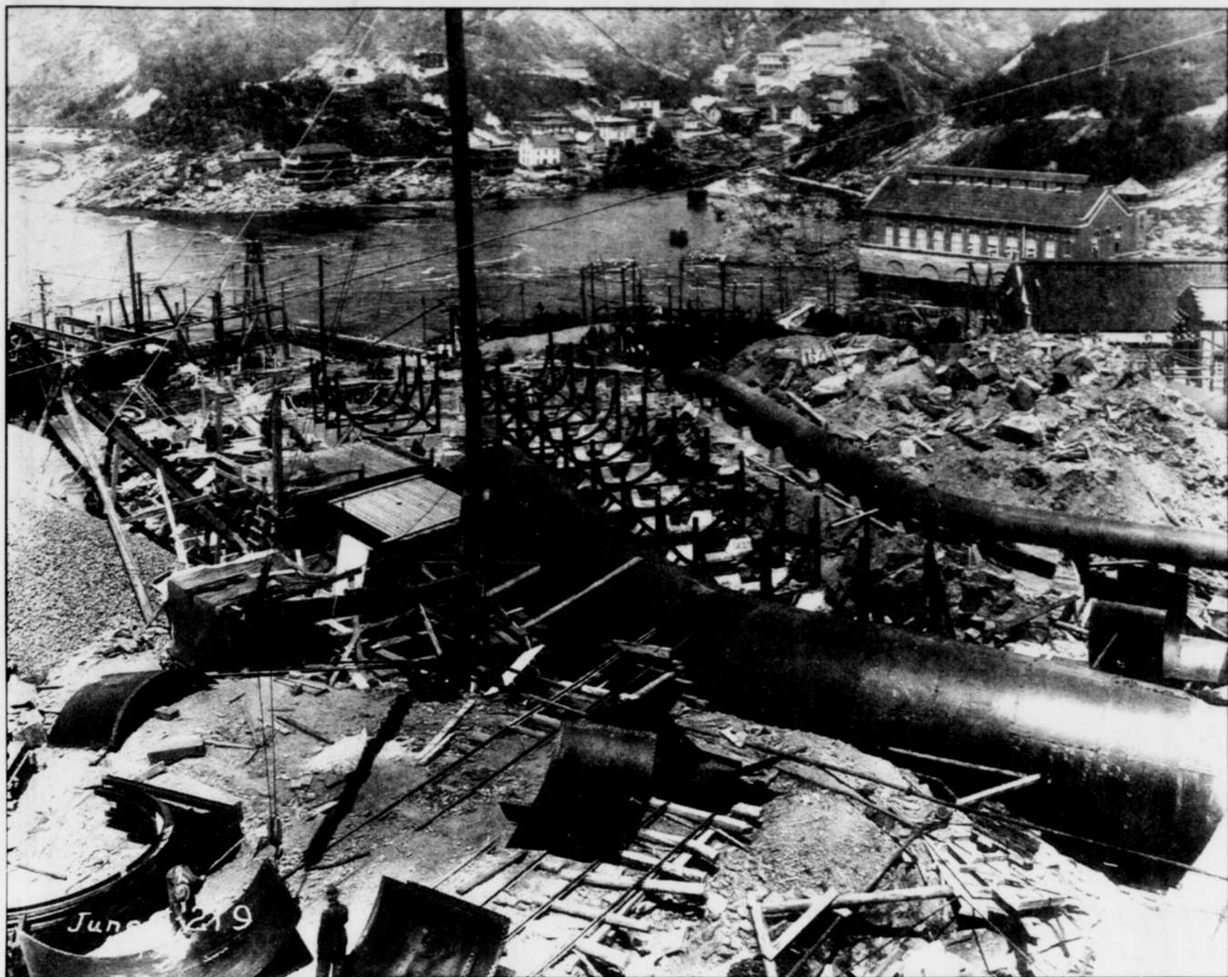
Dès 1911, la construction de la centrale Shawinigan 2 (et des conduites forcées en avant-plan) va bon train. On aperçoit, à l'extrême-gauche, la centrale Shawinigan 1 de la Shawinigan Water and Power ainsi que la centrale appartenant à la Northern Aluminium Company (Alcan). A l'arrière-plan, une vue de la rivière Saint-Maurice et de Belgoville. (Photo: courtoisie du Centre d'interprétation de l'industrie)
