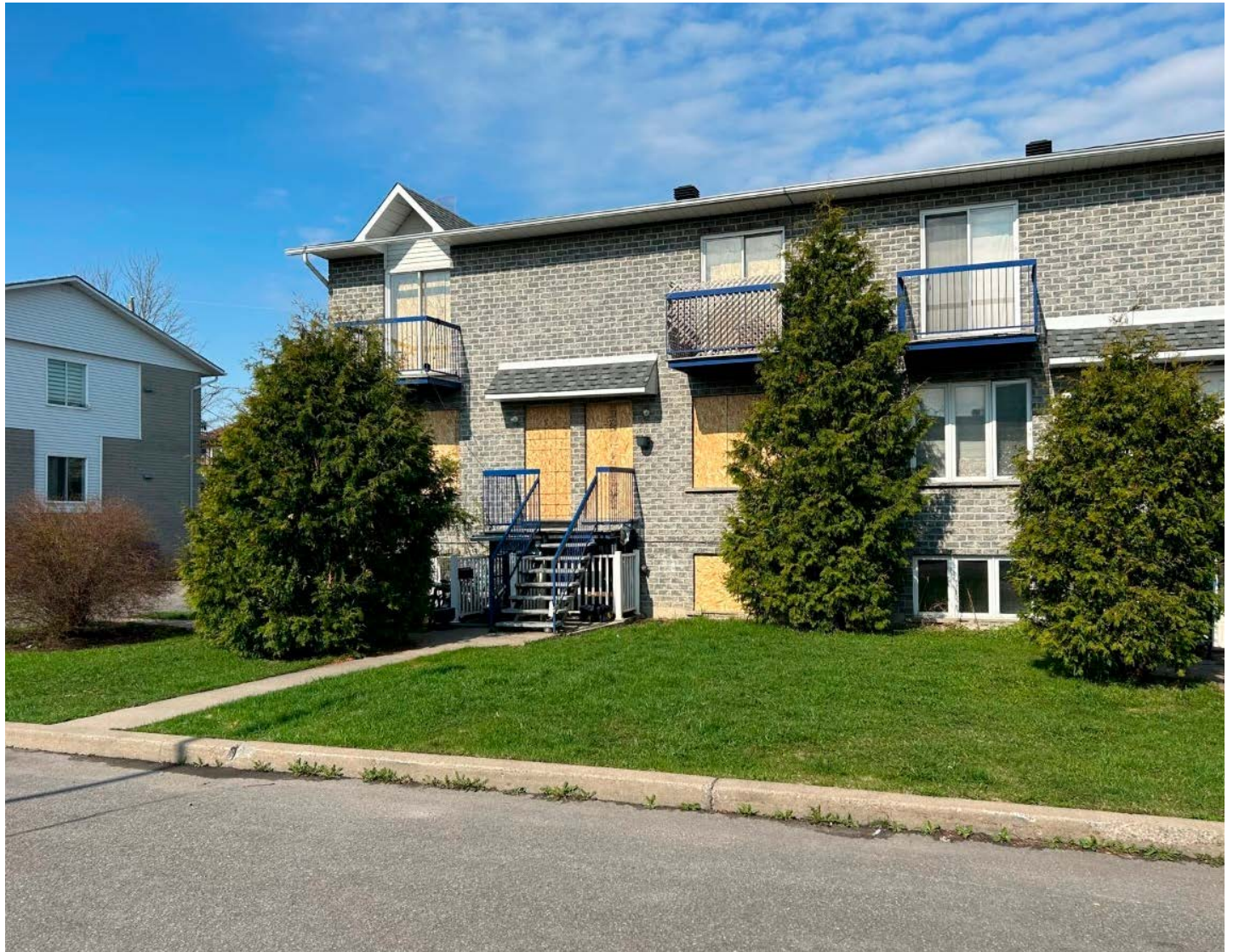
Plusieurs immeubles affichent des portes et fenêtres barricadées pour éviter des squatteurs. (Photo : Julien Dubois)
