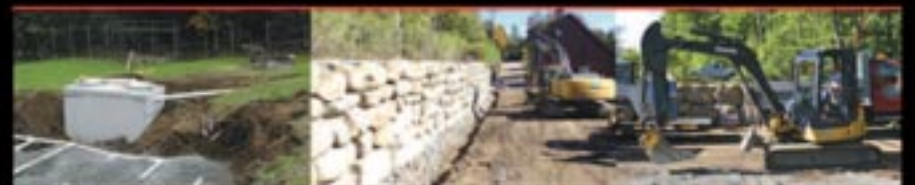
INSTALLATION DE FOSSE SEPTIQUE
