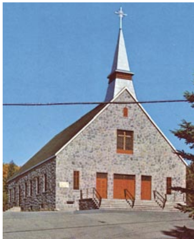
Chapelle Ste-Anne du lac Connelly, rénovée vers 1970.
