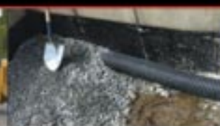
RÉPARATION DE DRAIN FRANÇAIS
