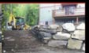
MUR DE PIERRE
