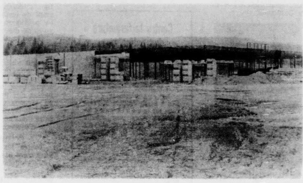
Structures d'acier Le futur Centre d'Achats "Carrefour Frontenac" situé à l'angle du Boulevard Smith et du boulevard Ouellette à Thetford Mines devrait être prêt le printemps prochain. Déjà on a installé les structures d'acier et commencé de poser les blocs de béton.
