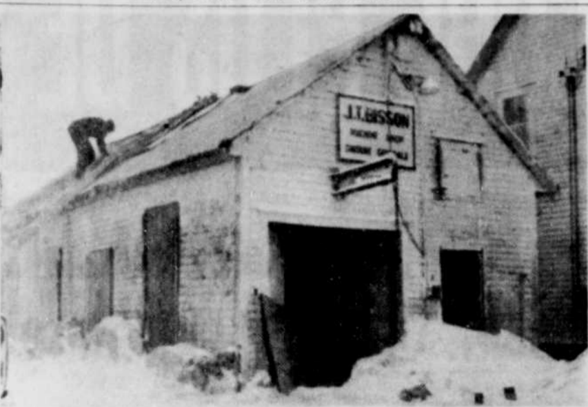
GARAGE RAVAGE PAR LES FLAMMES: Le garage de M. Jean-Thomas Bisson, de Robertsonville, a été lourdement endommagé par l'élément destructeur tôt hier matin. Le feu aurait été provoqué par l'explosion d'une fournaise, et les pertes s'élevaient à quelque $4,000.
