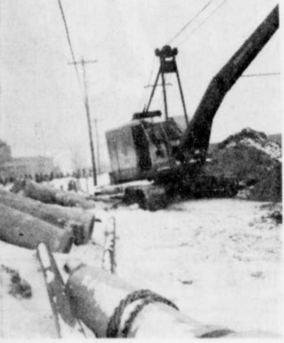
TRAVAUX D'AQUEDUC — D'importants travaux d'aqueduc sont présentement en cours, entre l'École de métiers et la future École du meuble et du bon-ouvrier, le long de la route 5. Les travaux ont été confiés à la firme Cormier Limitée.
