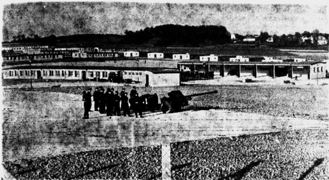
Voici une vue du nouveau camp permanent du Princess Patricia's Canadian Light Infantry dans la région de Soest, Allemagne. Ce genre de camp est maintenant fourni à toutes les unités canadiennes dans ce pays. A l'avant plan, on remarque un groupe fantassin s'entraînant à utiliser le canon anti-chars de 17 livres.
