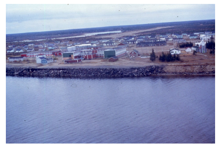
Village de Fort-George en 1977, déménagé au site de Chisasibi (Photo Marcel Couture)
