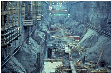
Centrale LG2 en construction en 1978 (Photo Marcel Couture)
