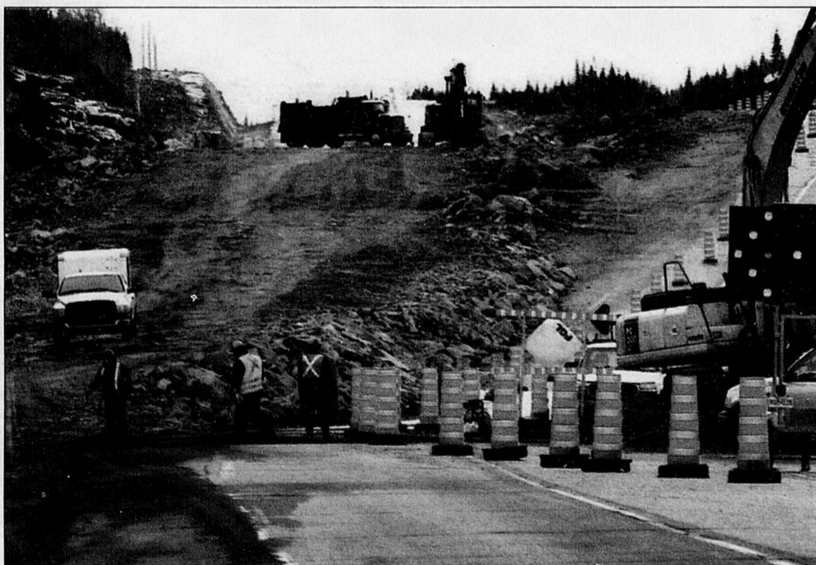
TRAVAUX SUR LA 175 - La circulation a été perturbée pendant toute la journée d'hier au kilomètre 219 de la route 175 dans la Réserve faunique des Laurentides. Les entrepreneurs routiers procèdent à l'installation d'un ponceau dans le secteur de l'ancienne barrière nord, près de Laterrière. Les travaux se poursuivent encore aujourd'hui entre 7h et 16h30. La vitesse sera réduite à 70 km/h.
