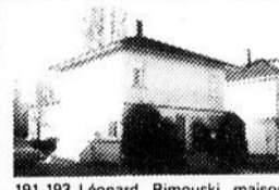
191-193 Léonard, Rimouski, maison à 2 logements, bien situé terrain aménagé, entrée asphaltée, bon investissement. Benoit Dupont 724-9509
