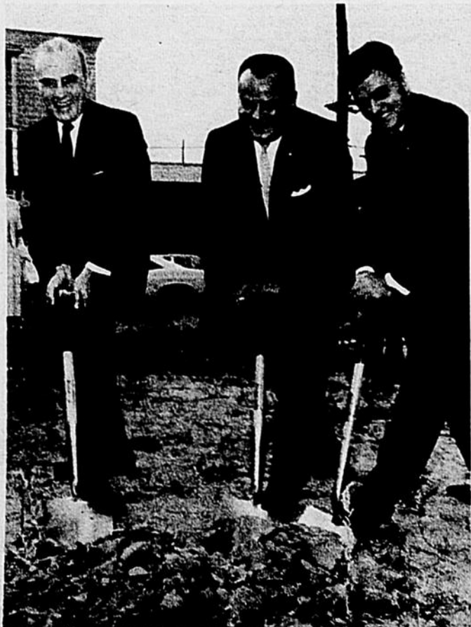
Le maire Jacques Lafontaine, M. André Gagnon, président du Conseil central des syndicats nationaux, et M. Jacques Dion, trésorier de la CSN, qui ont présidé l'inauguration des travaux du nouvel édifice des syndicats en levant la première palette de terre. (Photo-Bredou)
