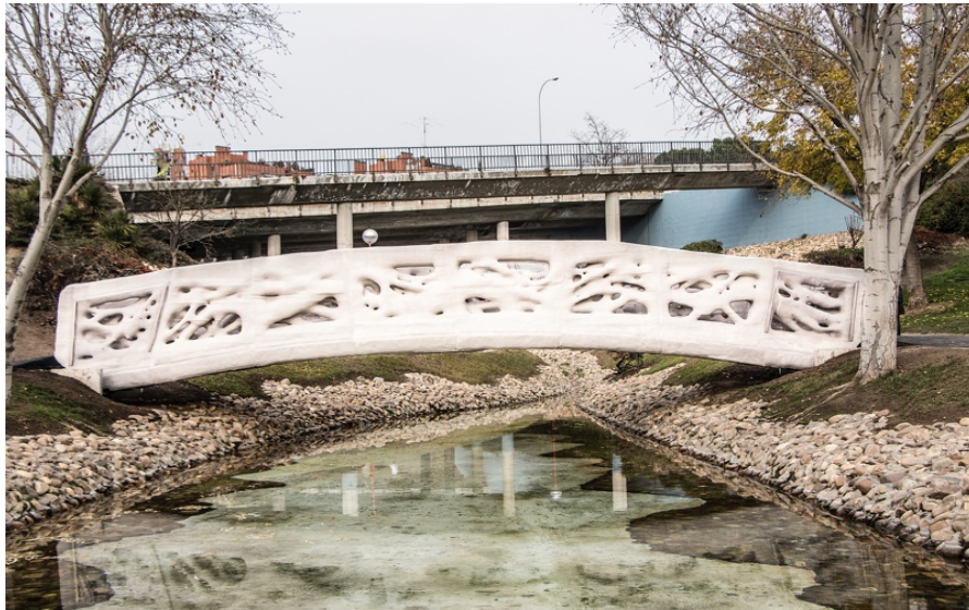
Figure 17 : Premier pont piétonnier imprimé en 3D à Madrid par Enrico Dini (© IAAC,2016)
