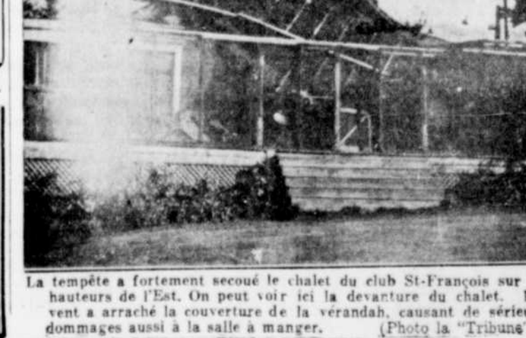
La tempête a fortement secoué le chalet du club St-François sur les hauteurs de l'Est. On peut voir ici la devanture du chalet. Le vent a arraché la couverture de la veranda, causant de sérieux dommages aussi à la salle à manger. (Photo La "Tribune")
