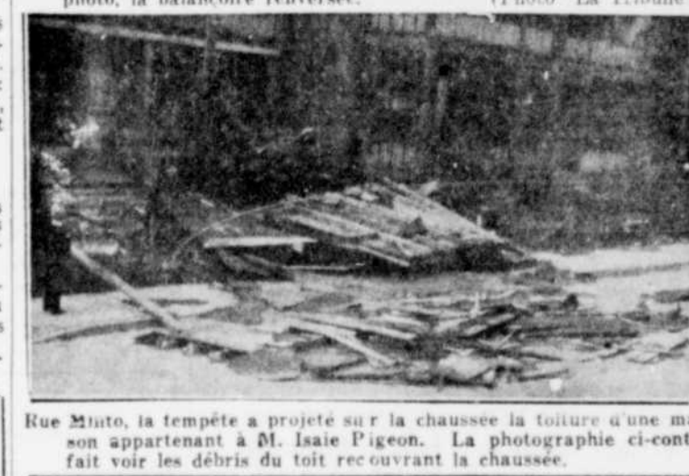
Rue Minto, la tempête a projeté sur la chaussée la toiture d'une maison appartenant à M. Laie Pigeon. La photographie ci-contre fait voir les débris du toit recouvrant la chaussée.
