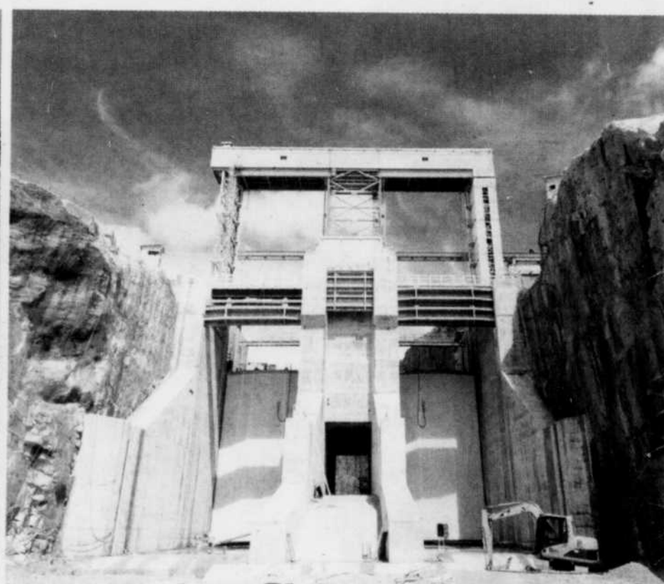
ÉVACUATEUR DE CRUES (HYDRO QUÉBEC)
