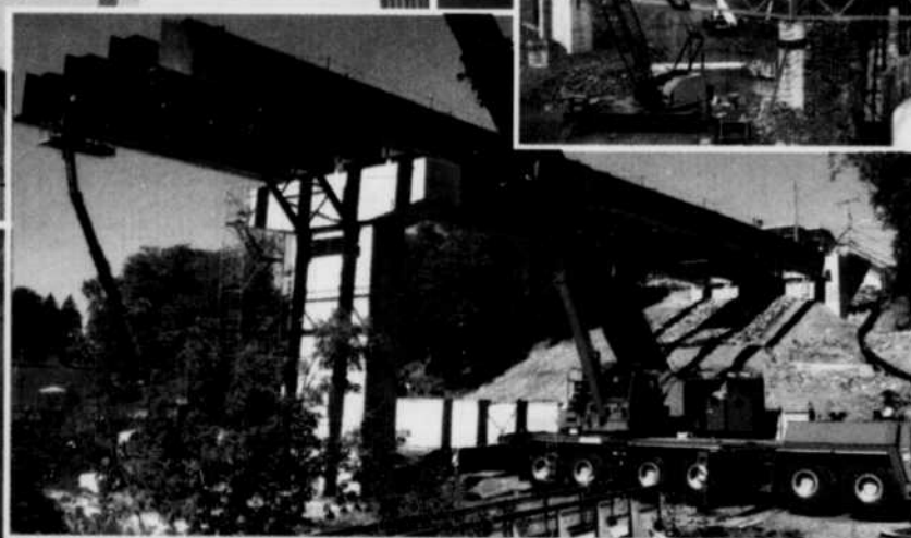
MINISTÈRE DES TRANSPORT DU QUÉBEC, PONT RIVIÈRE SHAWINIGAN, GRAND-MÈRE, QUÉBEC
