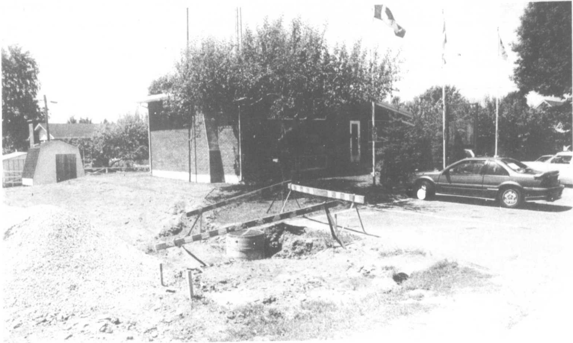
Une partie des travaux effectués aux abords de l'hôtel de ville d'Otterburn Park.
