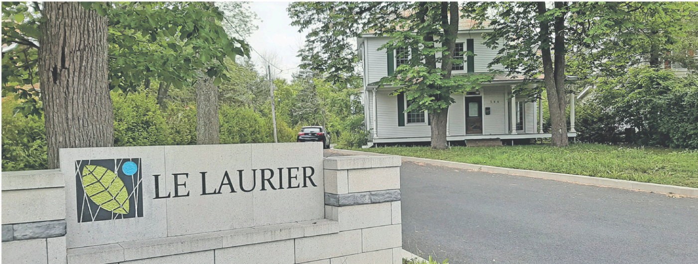
Le propriétaire de la maison Maison Eugène-Desnoyers, située derrière le complexe Le Laurier, pourra procéder à une démolition partielle de la maison. Photo Vincent Guilbault | L'Œil Régional ©
