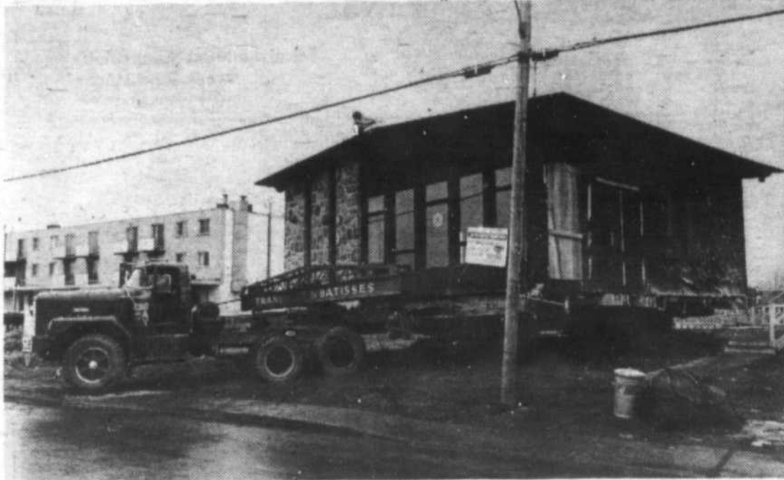
Le bâtiment qui logeait la Caisse populaire de Sainte-Maria Goretti depuis 1966 est parti sans bruit le 19 novembre. Son emplacement servira de stationnement à la nouvelle. [Photos: Christian Hébert].
