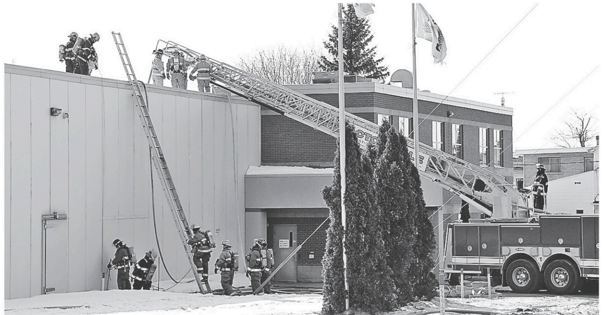
Un problème dans la chambre électrique de l'ancienne usine Olymel de Saint-Valérien-de-Milton est responsable de l'incendie qui a causé pour plusieurs milliers de dollars de dommages, mercredi.
