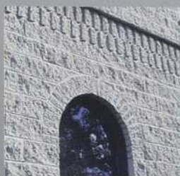
Collège Vanier Patrice Poirier, architecte
