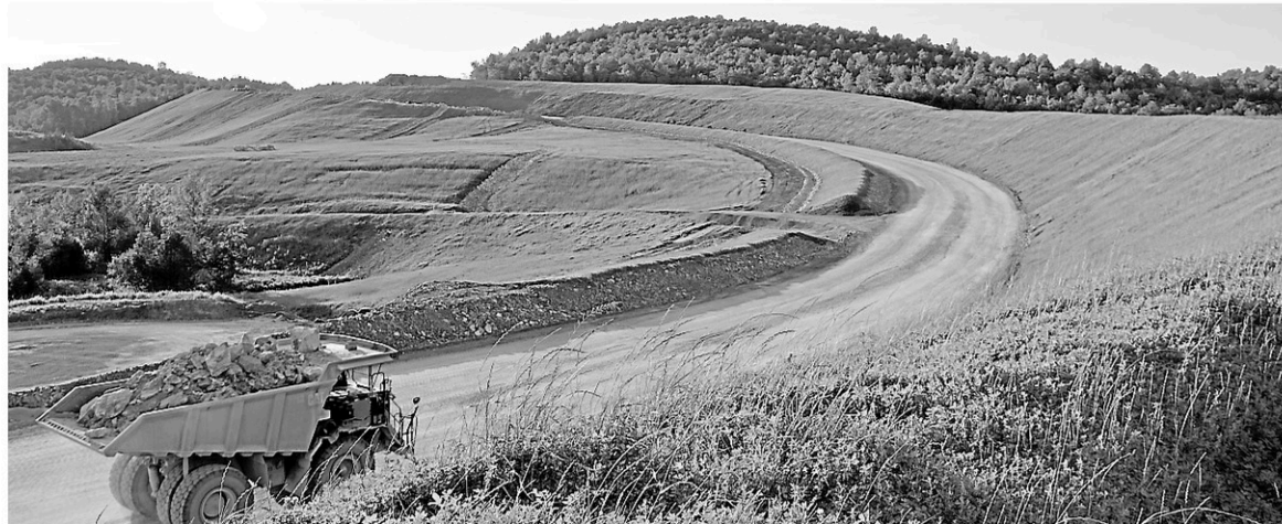
La transformation de la carrière 5 en espace vert se poursuit à Dudswell. En moins d'un an, le tiers de la carrière a été remblayé avec de la roche non utilisée dans les opérations de Graymont. — PHOTO FOURNIE
