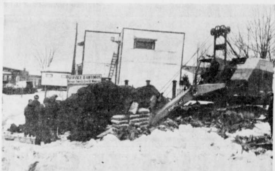
PALAIS DES SPORTS. — Les travaux préliminaires à la construction du Palais des sports de Sherbrooke ont débuté hier. Les ouvriers ont commencé à couper les arbres sur le terrain où sera érigé le Palais des sports, en face de l'arène actuelle. On se prépare aussi à démolir les bâtisses de bois qui s'y trouvent. (Photo La Tribune, par Studio Breton)
