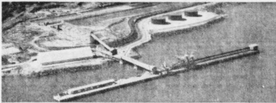
Les installations actuelles de Pointe-Noire
