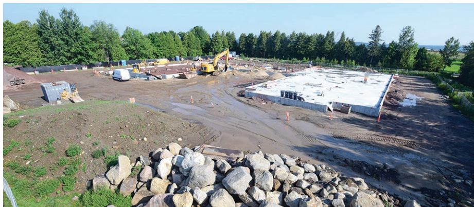
Le chantier de l'école Saint-Philippe à Saint-Jérôme.
