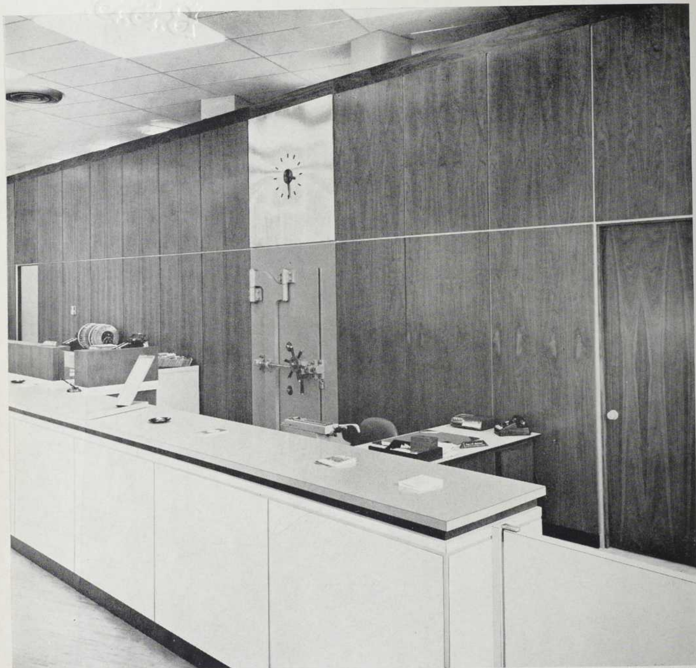
Cette succursale de la Banque de Nouvelle-Ecosse à Montréal est décorée de panneaux de noyer Weldwood en placage tranché, joliment assortis. Architectes: Schrier et Kessler.
