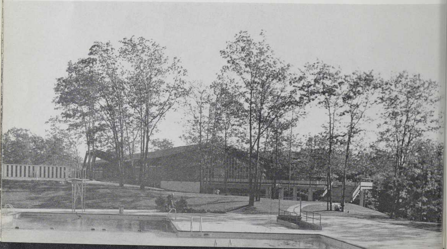
Faces nord et nord-est, vues de la piscine
