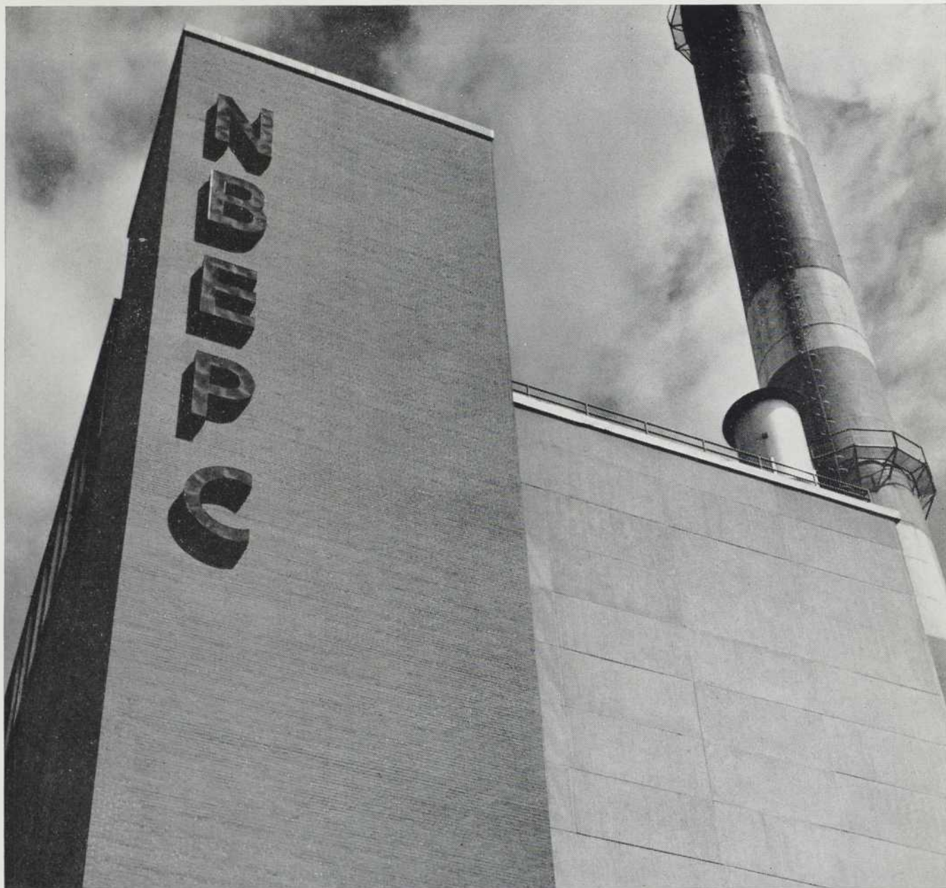
La centrale thermique de Saint-Jean, de la Commission de l'énergie électrique du Nouveau-Brunswick. Architecte et ingénieur: H. G. Acres & Co. Ltd. Panneaux préfabriqués au POZZOLITH: Ocean Steel & Construction Co. Ltd. Fournisseurs de béton préparé: Joseph A. Likely Ltd. (Division du béton) et Chittick Ready Mix Concrete Ltd.
