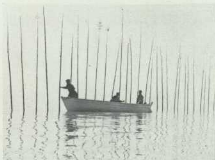
Le barrage, servant à capturer les Bélugas est terminé. Un dernier examen pour en assurer la solidité.
