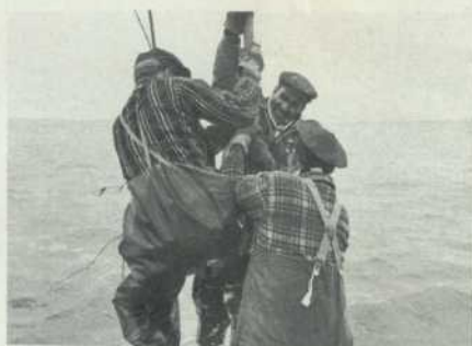
Première phase on plante les solides branches une à une.
