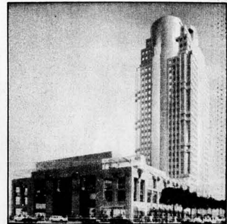
Avenue McGill College, va s'élever la tour du Montréal Trust, un complexe polyvalent comprenant une tour à bureaux de 30 étages et une galerie commerciale pouvant accueillir 150 boutiques et restaurants.
