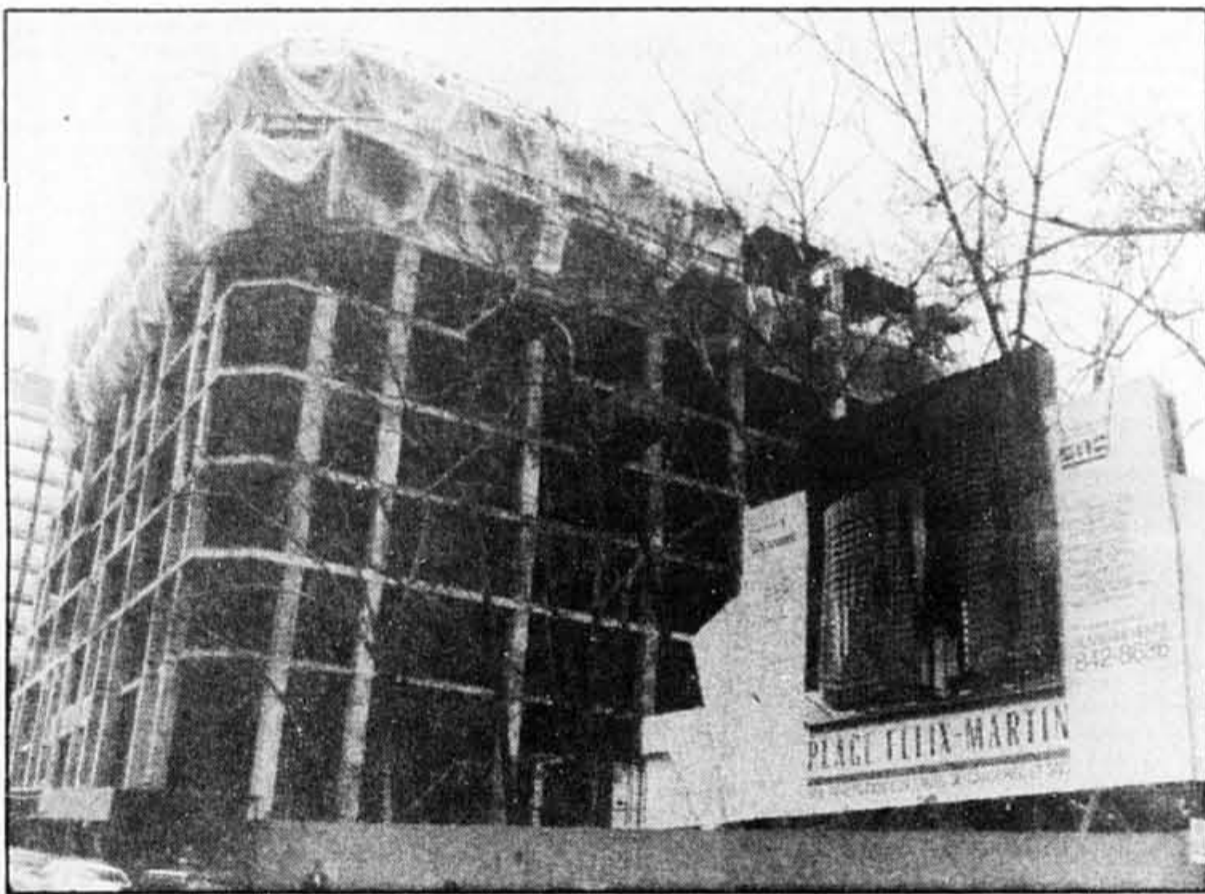
Les travaux en cours à la Place Félix-Martin.
