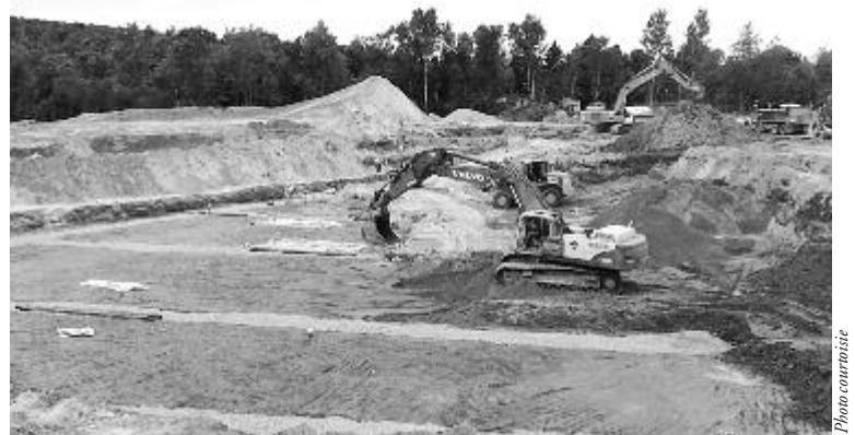
Le chantier de construction du troisième étang aérée de l'usine d'épuration de Prévost.
