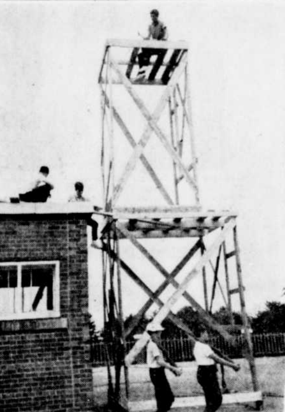
EN CONSTRUCTION. — Les techniciens poursuivent la construction de la rampe de lancement qui doit soutenir l'énorme fusée "Tour du Monde 2". Une réalisation des otéjistes du parc Dollard. A remarquer l'étrange surveillance exercée par deux gardes.
