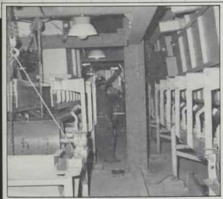
L'un des deux broyeurs de minerai installés sur la péniche, et pesant chacun 40 tonnes.
