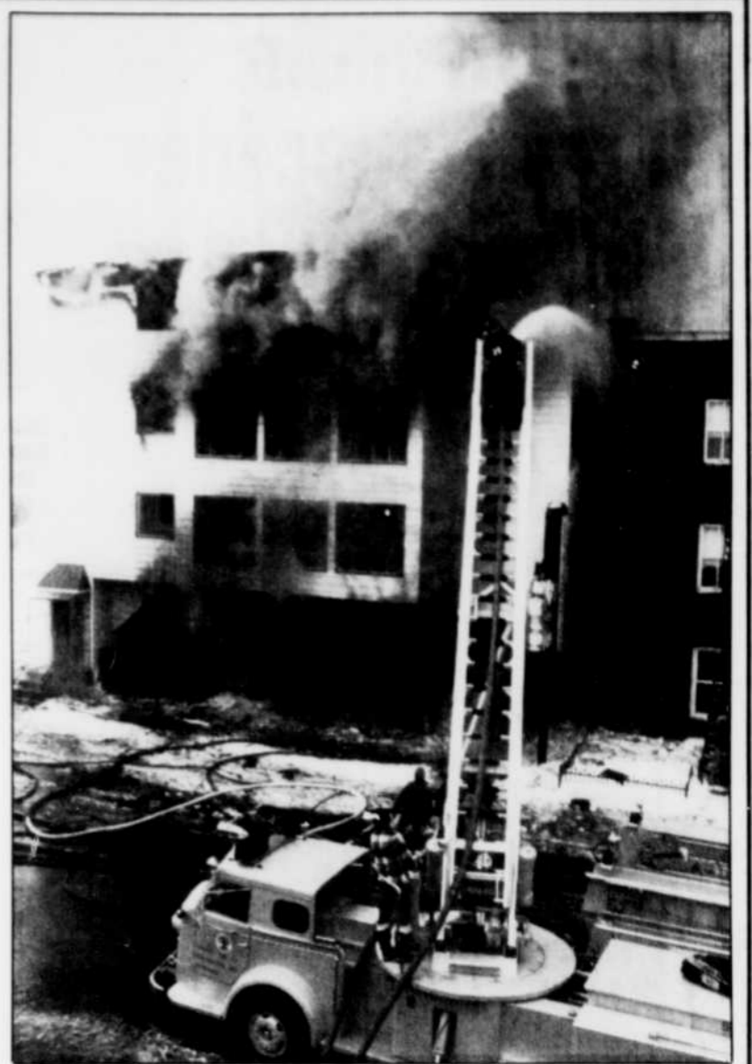
Les pompiers ont eu fort à faire pour empêcher que les flammes ne détruisent complètement l'immeuble voisin dont l'étage supérieur et les hangars situés à l'arrière ont été sérieusement endommagés.
