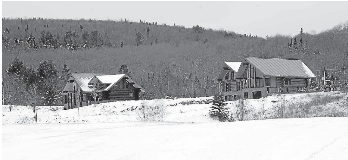
Deux propriétés en bois rond sont en construction sur l'immense propriété du Groupe Terrestria, dans le secteur Saint-Jean-des-Piles. —PHOTO: SYLVAIN MAYER.
