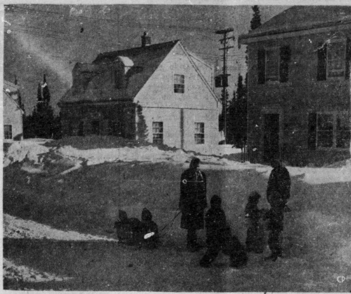
FACILITE DE LOGEMENT — On ne peut pas dire que les aventuriers du C.A.R.C. envoyés à Goose Bay éprouvent de grandes difficultés à se loger. Les autorités ont fait construire, à 1 mille du camp, 90 maisons dont la photo nous montre quelques-unes. Ce sont des habitations confortables, peintes de divers coloris. Les familles des aviateurs viennent s'y établir. De plus, on a converti en 100 appartements des édifices qui datent de la guerre (Photo CP)
