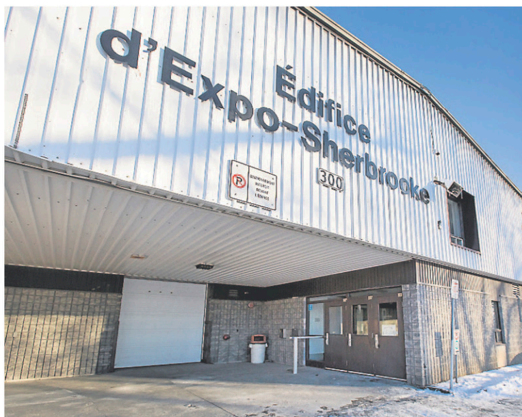
Sherbrooke propose un projet de 12 M$ pour rénover l'édifice d'Expo-Sherbrooke pour le rendre adéquat pour le club de gymnastique SherGym et même y accueillir le club de cheerleading ImpAkt. — PHOTO LA TRIBUNE, ARCHIVES
