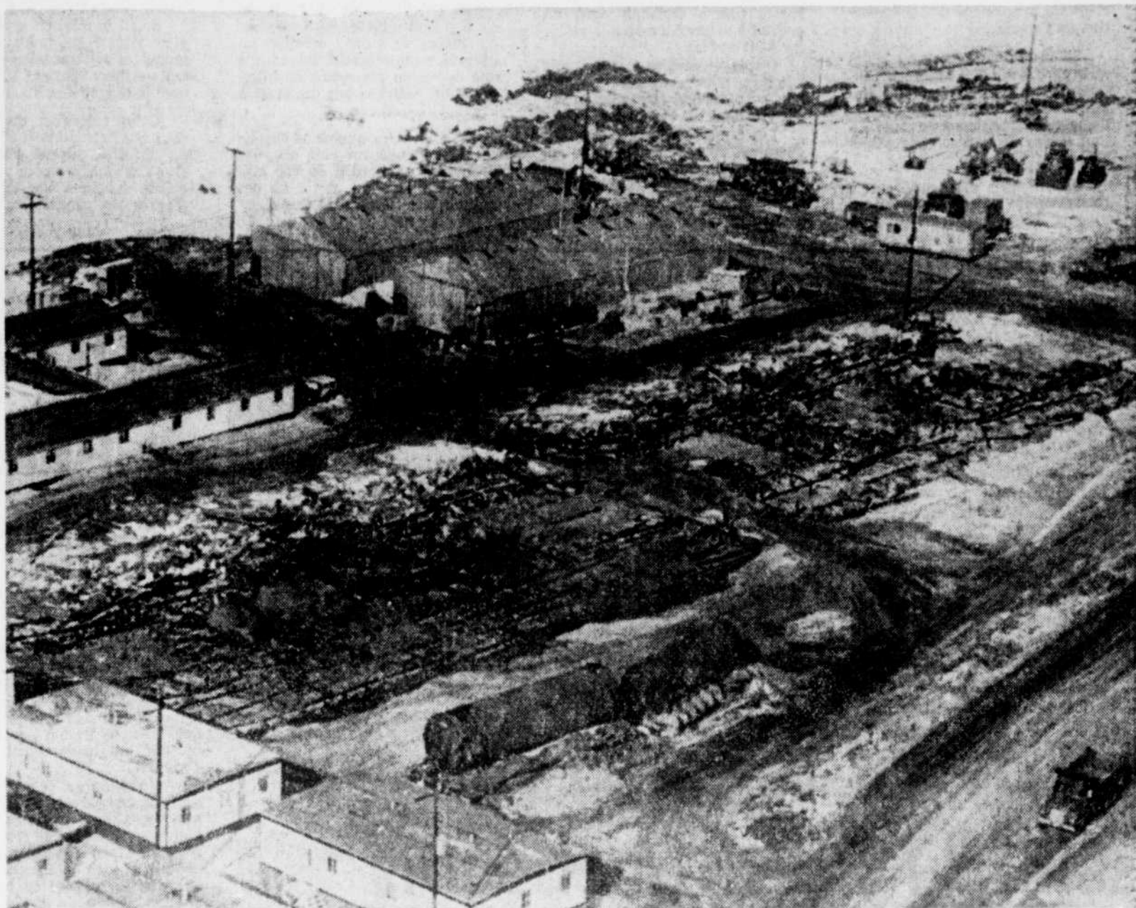
Le saccage du chantier LG-2, à la baie James, en mars 1974.
