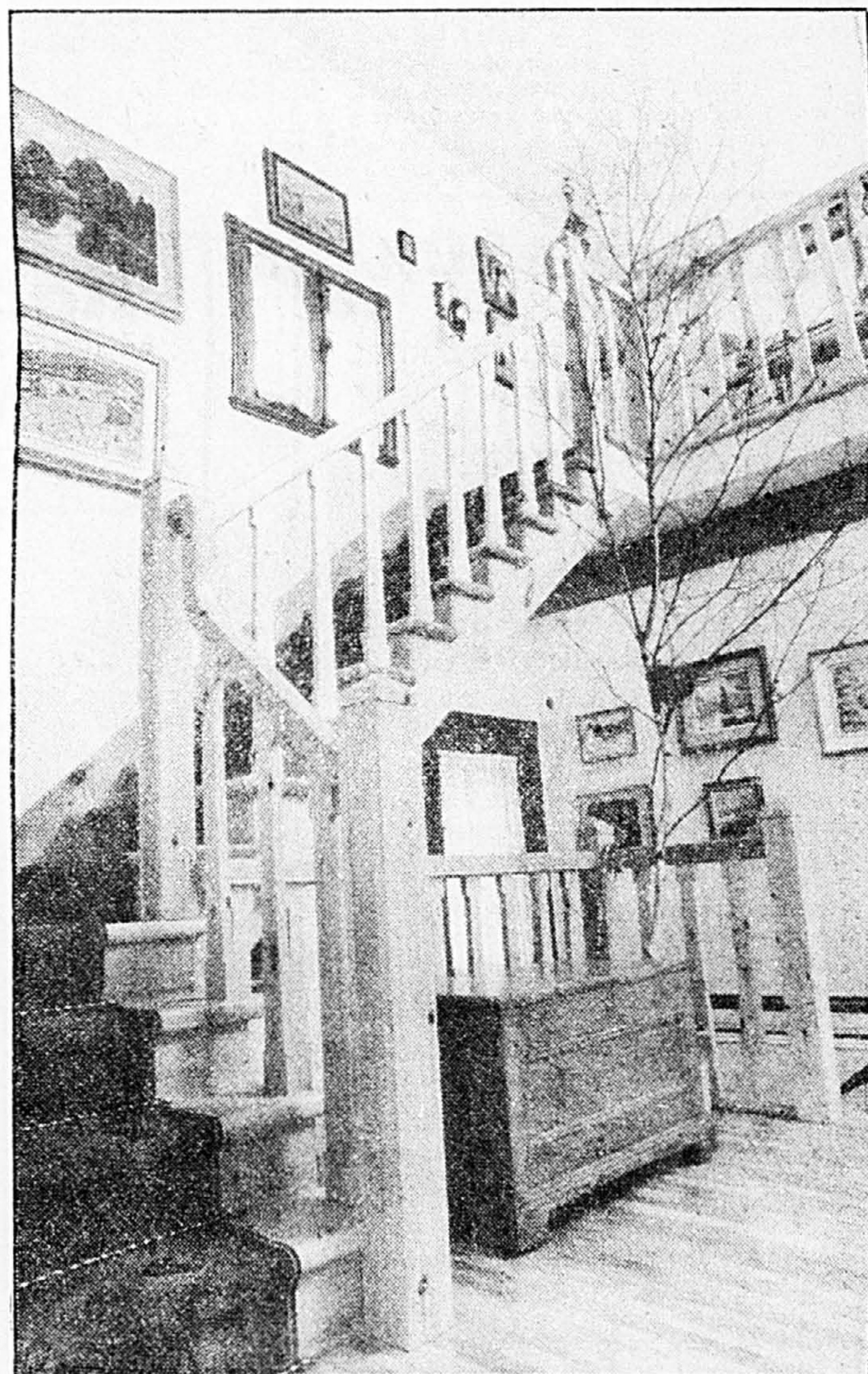
La maison de Monique est sans cloison. À l'étage on retrouve la même philosophie d'espace et de fonction. L'escalier qui y mène est en bois blond. À remarquer le «cou de butor» aux coudes de la rampe.
