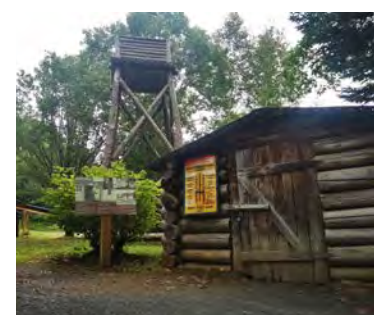
2 des 23 bâtiments sur les terres du Village du Bûcheron.
