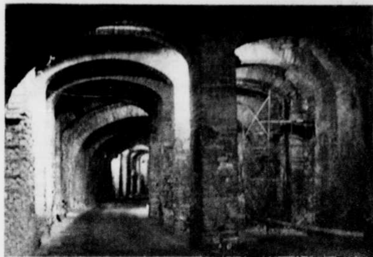
Les superbes tunnels de Guanajuato, uniques au monde.
