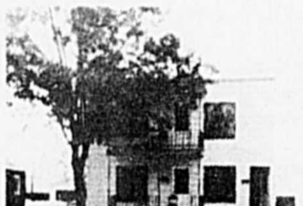
2586 - DUPLEX DÉCLIN D'AMIANTE, 2 x 5,5. Secteur Annexe. Besoin de rénovations.
