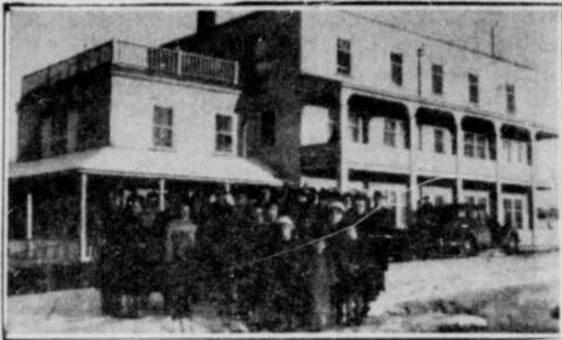
Pour loger ses employés, M. François Beaudoin construisit, en 1946, un spacieux hôtel de 52 appartements. On a une vue ci-haut de cet hôtel sis à proximité du Lac-aux-Canards, près de l'usine Beaudoin.
