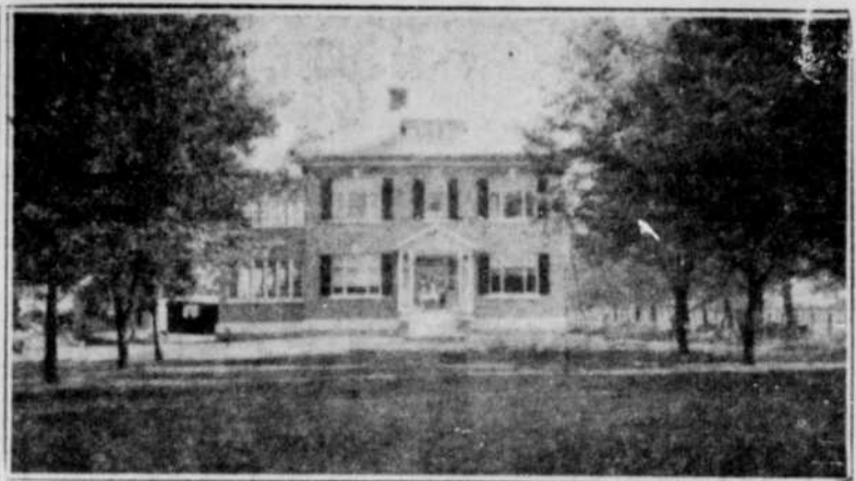
Ci-dessus, la photographie nous montre la magnifique résidence de M. J.-B.-Wilfrid Jolicoeur, à La Guadeloupe, Qué. Cette résidence, entièrement construite à l'épreuve du feu, s'élève au milieu d'un parterre soigneusement entretenu et décoré.
