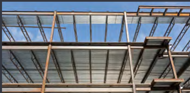
Hambro MD2000 sur structure d'acier traditionnelle
