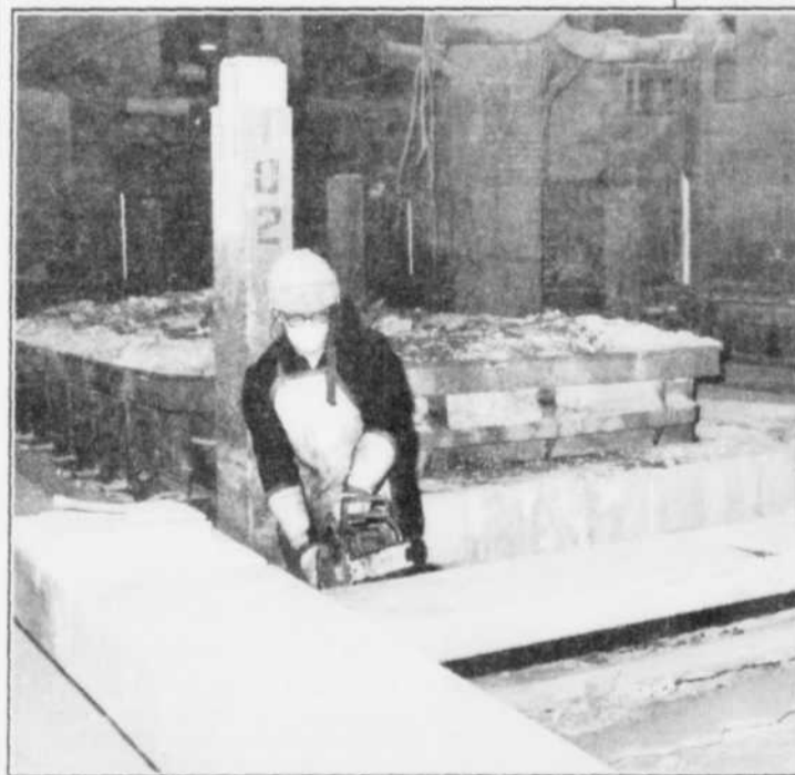
Rémi Beaumont effectue le sciage d'une barre omnibus cathodique.
