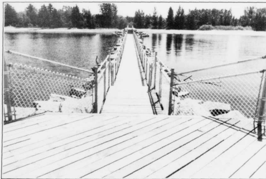
Voici, en deux plans différents, le nouvel épi aménagé à Saint-Gédéon. La première photographie nous donne une vue d'ensemble, tandis que la deuxième permet de mieux voir la promenade que pourront utiliser les utilisateurs.
