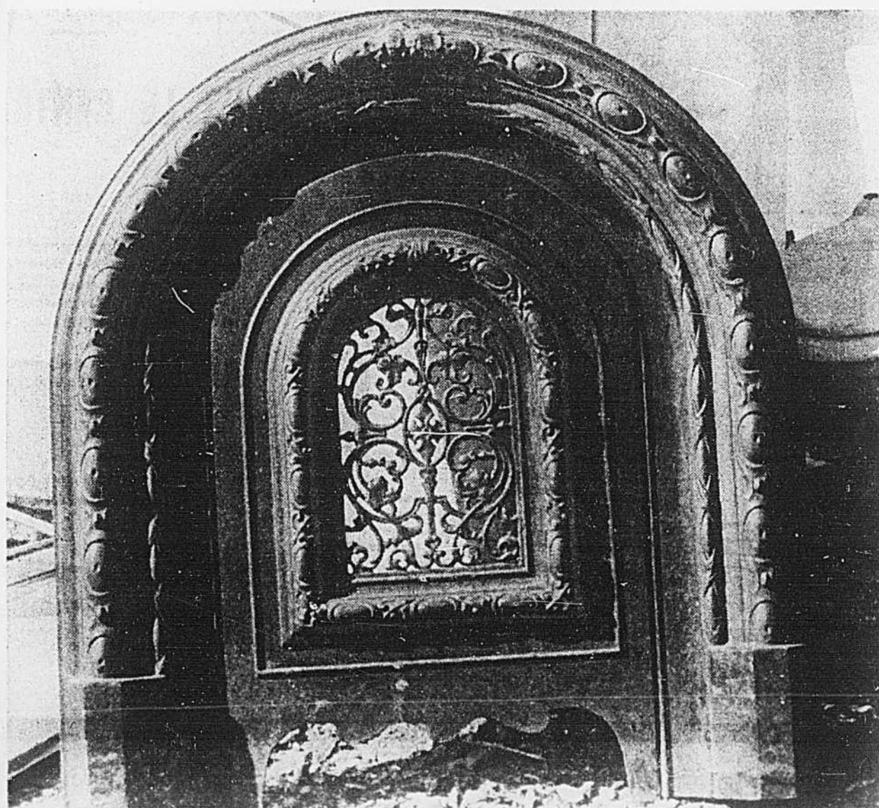
Une grille en fer ouvrage pour un foyer résidentiel. Les amateurs peuvent y assortir des montants en marbre clair ou gris-noir. Une pièce trouvée chez Bell Demolition.
